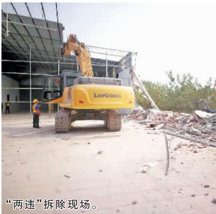
“两违”拆除现场。
