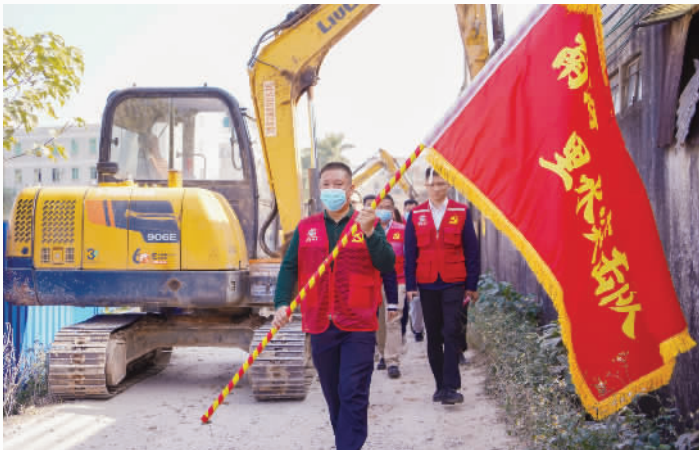
■2022年1月3日,里水突击队开展里湖新城及南海区有轨电车里水示范段项目拆除行动。(资料图片)
