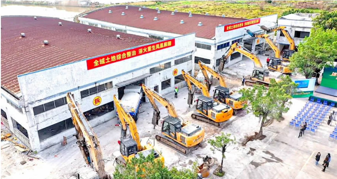
■里湖新城福南湾建设用地腾退项目拆除现场。
