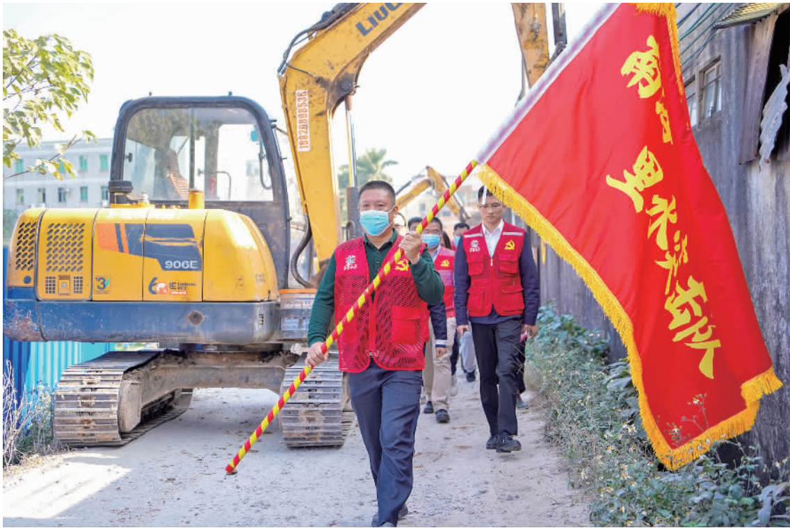
里水突击队开展里湖新城及南海区有轨电车里水示范段项目拆除行动。 陈家俊/摄
