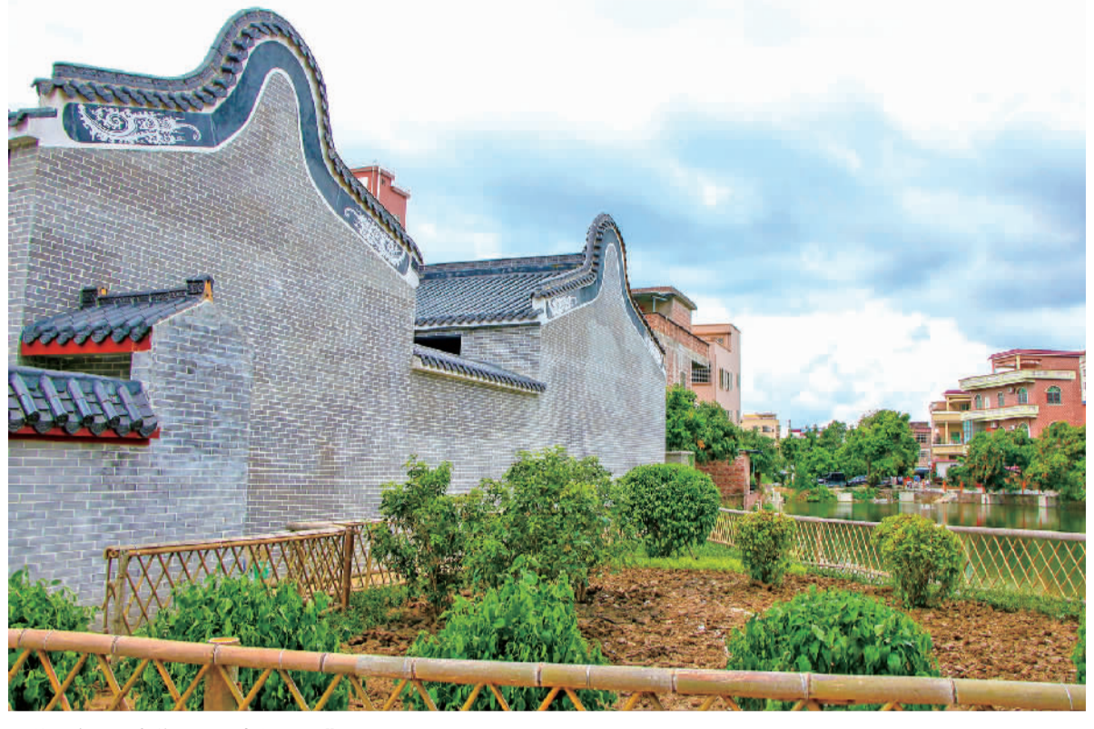
■社区在居民房前屋后打造“四小园”。
