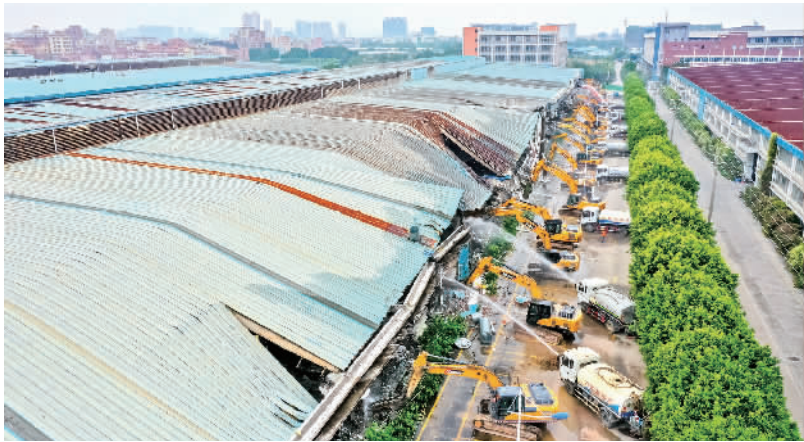
■里水启动东部工业园千亩连片厂房拆除工作。
