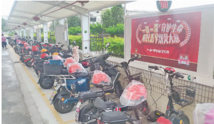
■柏悦华府小区新启用的电动自行车充电桩。 通讯员供图
