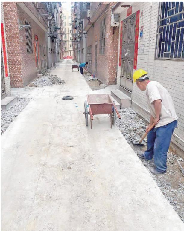
葡萄苑东区破损的巷道已经拆除,工人们紧锣密鼓地铺着水泥。
