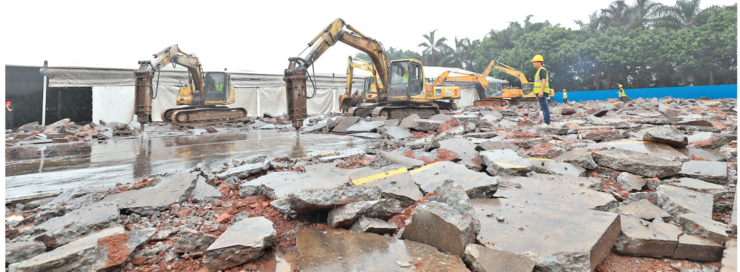
■里水镇东部工业园片区拆除现场。
