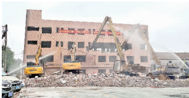
■里水大冲科技生态工业园项目拆除现场。
