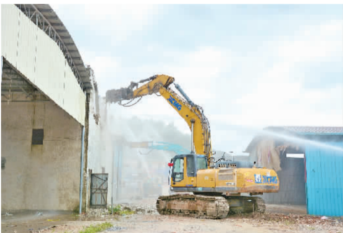
钩机进场拆除废旧厂房。
