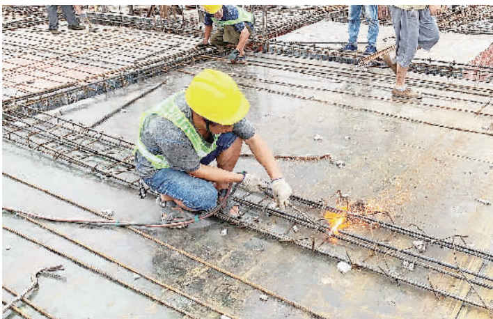
■工作人员拆除顶层违建。
