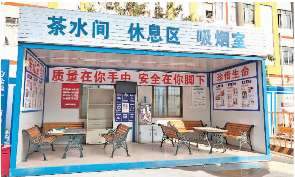
南海双语实验学校施工现场张贴有疫情防控宣传海报。
