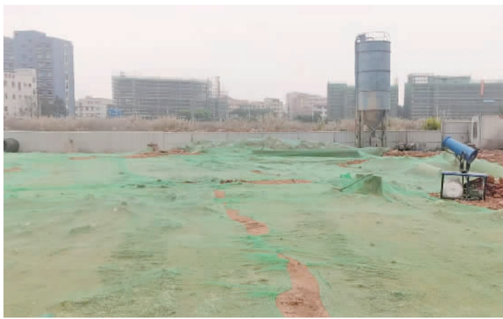
工地整治后,不再有扬尘污染。
