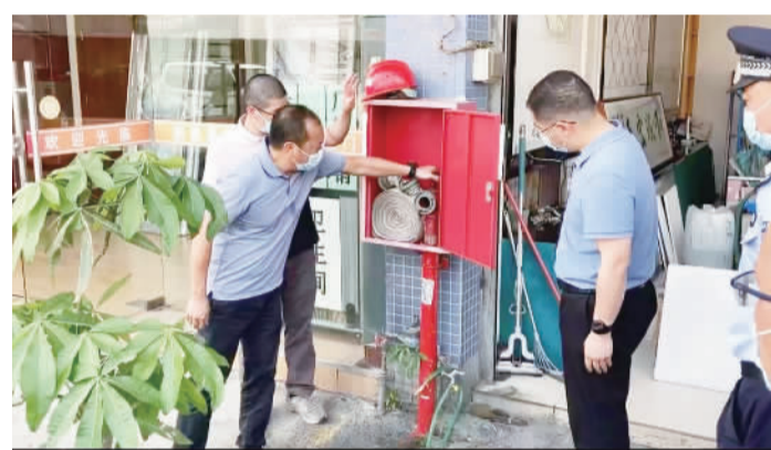
■检查组检查市场消防设施。
