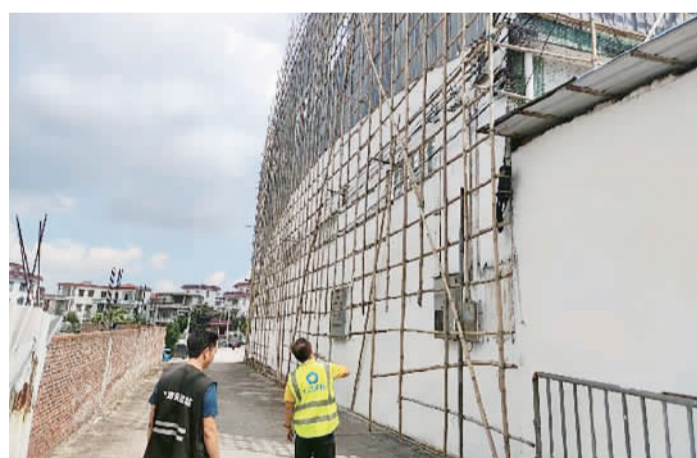
■网格员接到投诉到施工现场了解情况。
