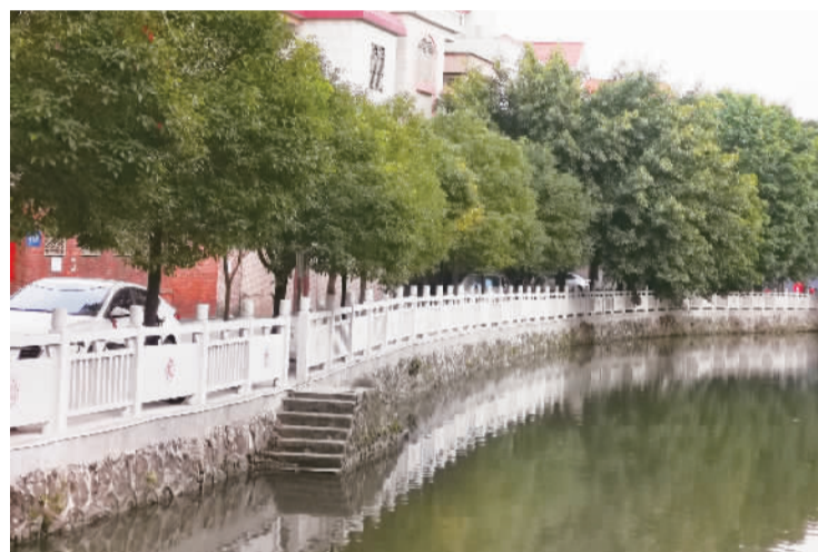
■水南社区河涌边护栏换上新装。
