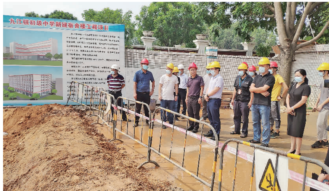
■检查组到在建工地检查安全生产情况。
