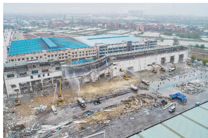
九江拆除临港国际产业社区的一处旧厂房。
