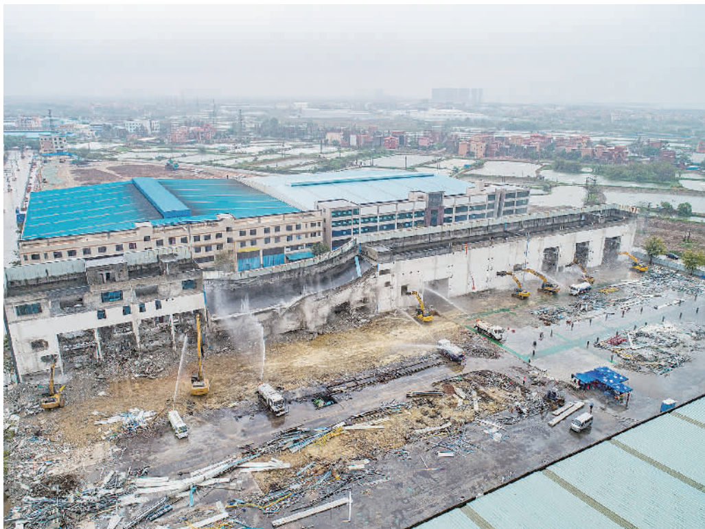
■九江临港国际产业社区加快升级改造步伐,图为此前拆除一处旧厂房。
