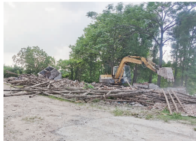
■工作人员操作钩机拆除违建。
