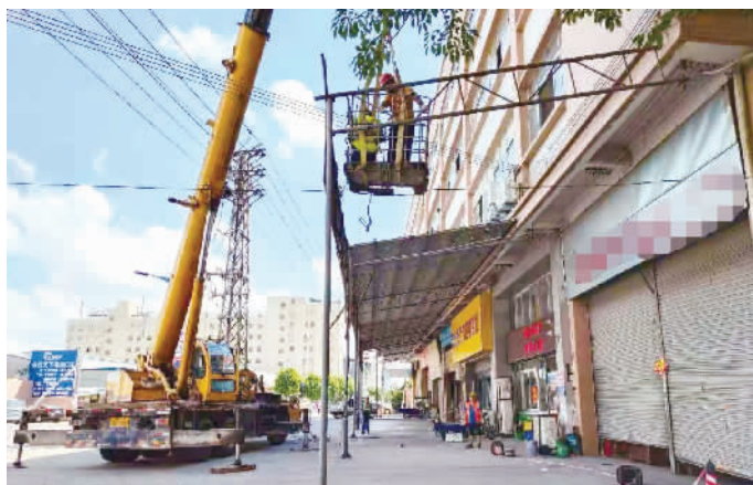
■工作人员拆除违建铁棚。
