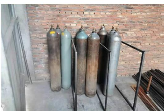
燃气瓶已安装防倾倒装置,现场安全隐患得到排除。
