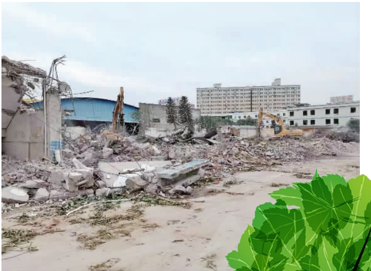
■村尾项目拆除现场。
