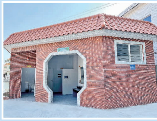
新龙村龙涌经济社新建的公厕设施齐全,获村民点赞。
