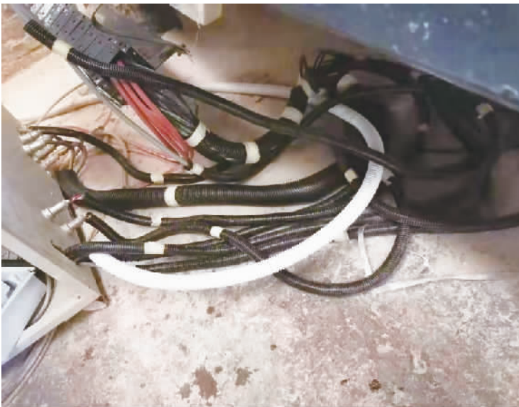
■企业对厂内的生产机械和电器设备的电线进行套管处理。(通讯员供图)
