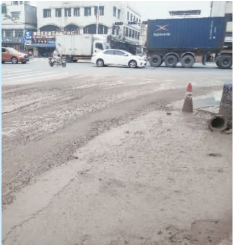
■路面有遗撒的泥土,存安全隐患。
