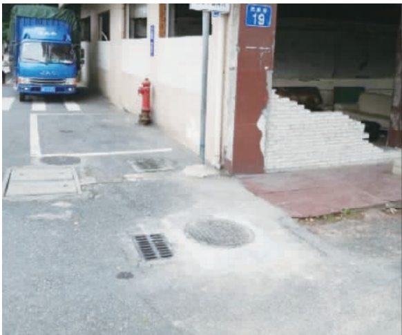
■缺失的井盖已重新换上。
