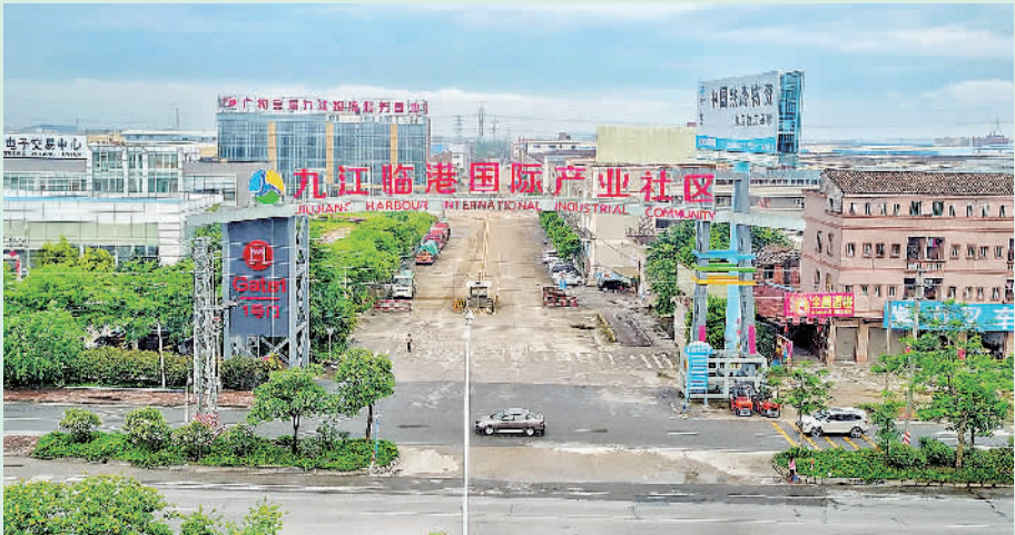
■临港国际产业社区现状。
