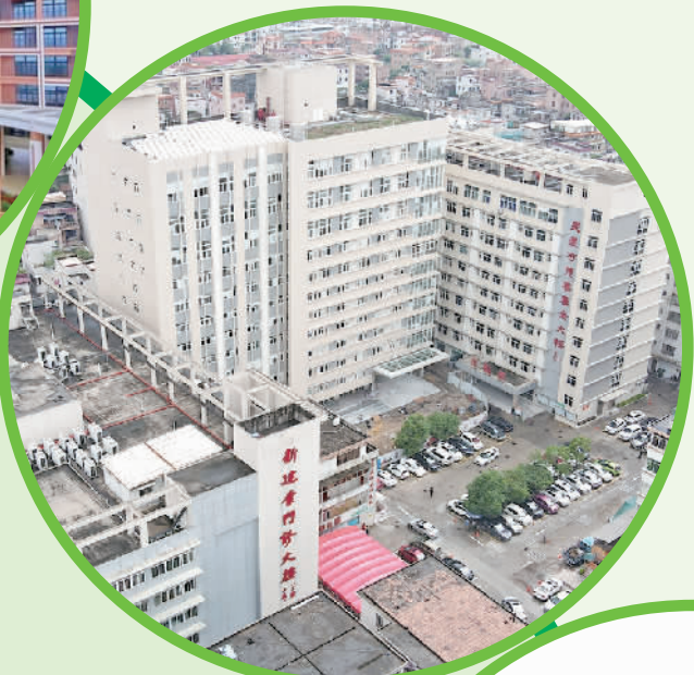
▲南海区第九人民医院新建的“住院医技大楼”，预计年底投用。
