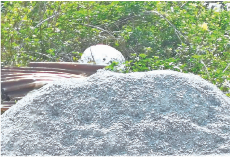
■镇涌二路133号附近,占道堆放建筑材料。
