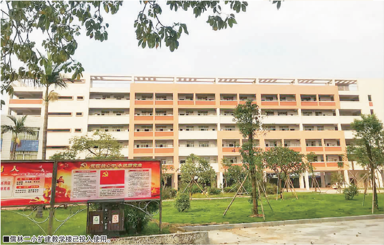
儒林二小扩建教学楼已投入使用。
