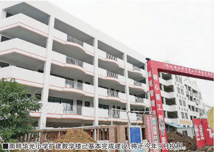
南畔华光小学扩建教学楼已基本完成建设,将于今年9月投用。
