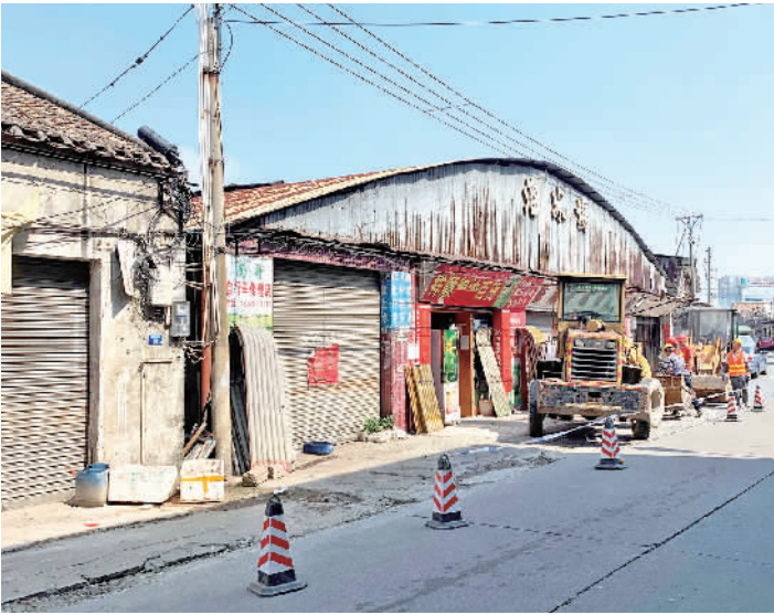
■工作人员拆除违建的广告牌。
