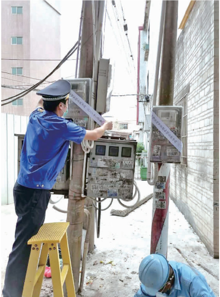
■执法人员对违建工地进行停电处理。
