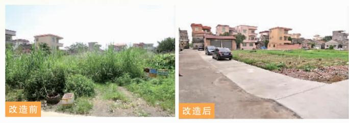
项目介绍:项目位于长龄村二队68号前,该处多年来只有一条小路,路边杂草丛生,且该旁边是个鱼塘,存在一定的安全隐患。项目对该小路进行升级改造,对原来的路面铺设了水泥路面实现了硬底化。考虑到安全问题,在鱼塘边加装了安全护栏。
