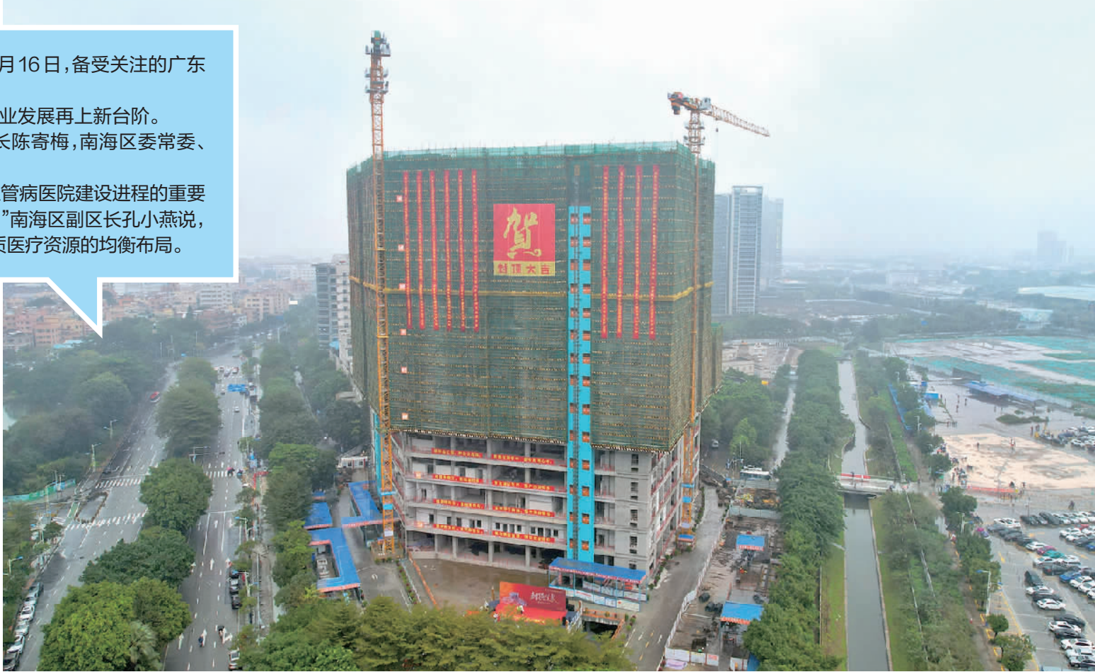
■广东省人民医院南海医院心血管病大楼封顶。
