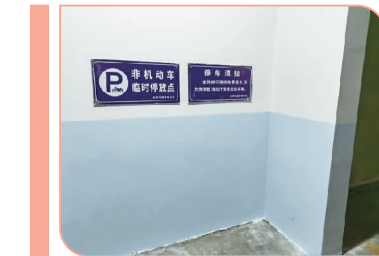
通过议事机制,翠颐社区翠竹苑和百合苑共26个楼道墙面已完成翻新。
