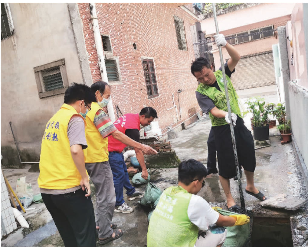
■大圩社区街坊会“特勤中队”小分队成员合力疏通下水道。
