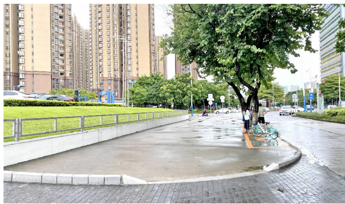
■改造后人行道出入口与路面持平,方便市民出入。
