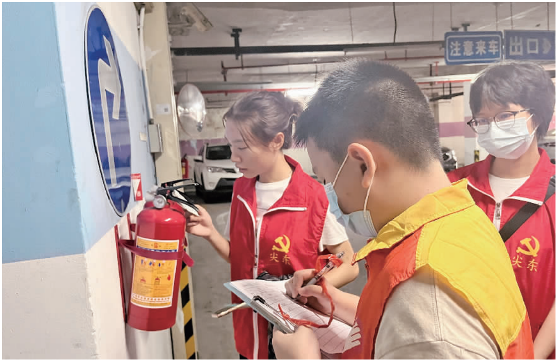
■青少年检查楼道消防安全。
