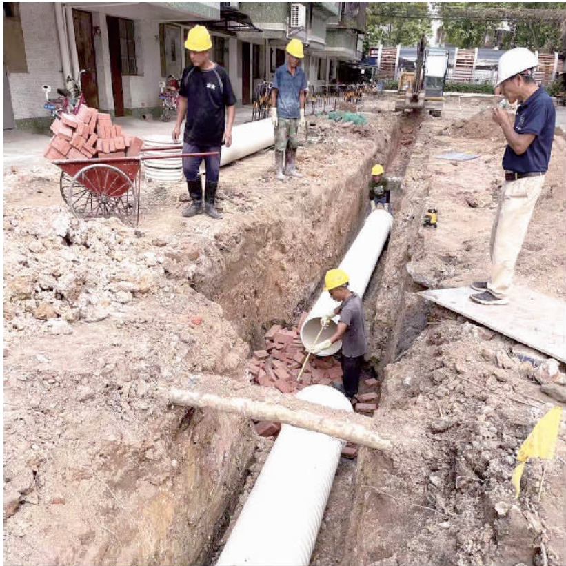
■老旧小区改造过程中,施工方挖开路面重新铺设排水管道。(资料图片)
