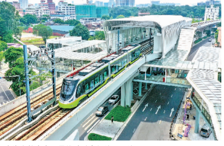
南海有轨电车一号线驶过高架站平西站。珠江时报记者/廖明璨 摄
