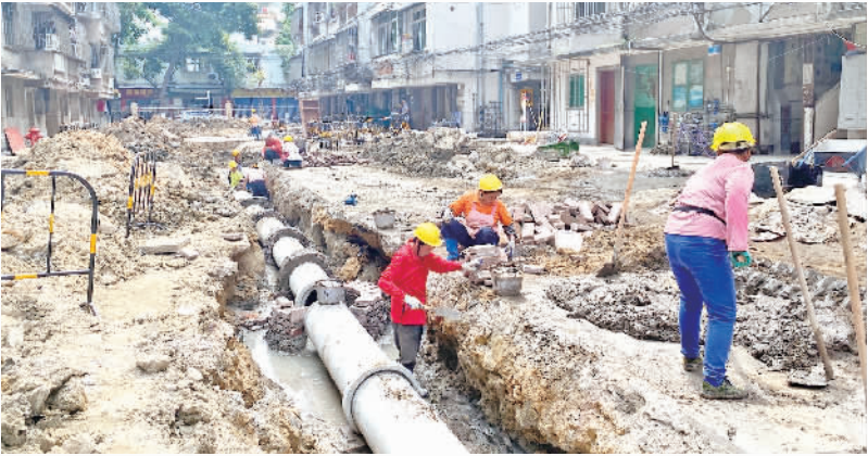
■桂城桂一社区的海棠村小区升级改造，工作人员在重新铺设地下管网。
