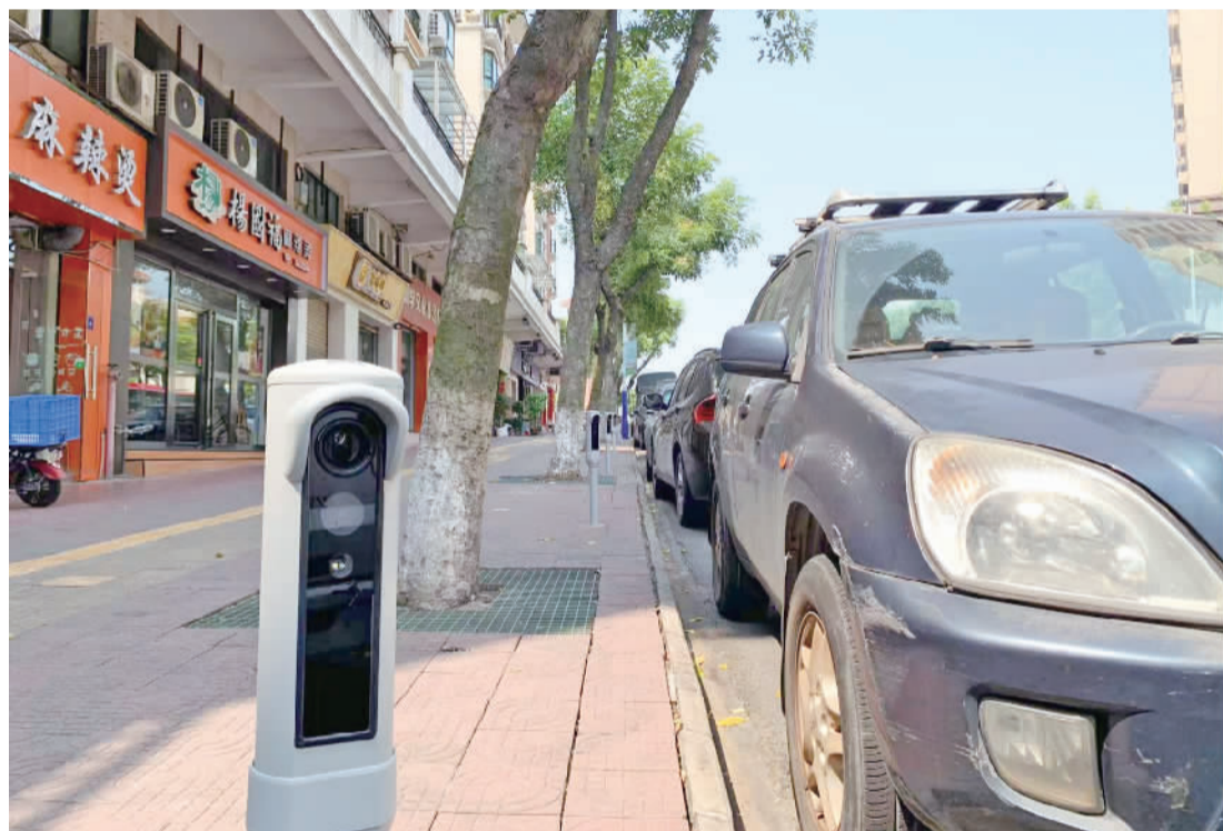
丹灶有为大道路段智能设备安装完成。
