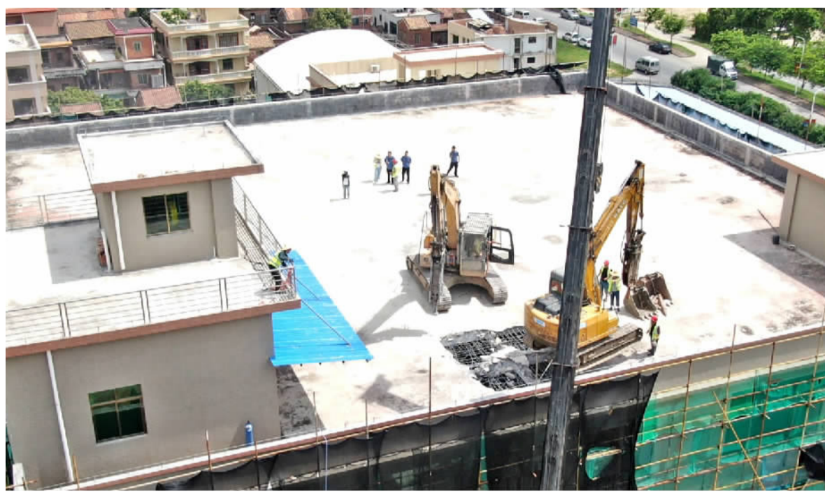
■打桩机拆除顶楼地板。
