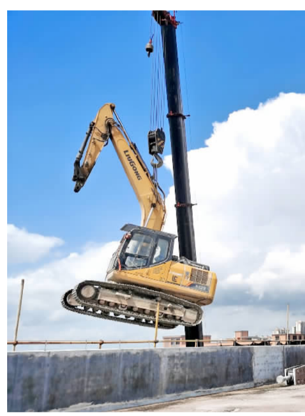
■施工队用吊机将打桩机、炮机等运至顶层。
