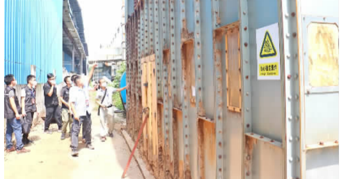
■检查组对企业集尘仓进行检查。
