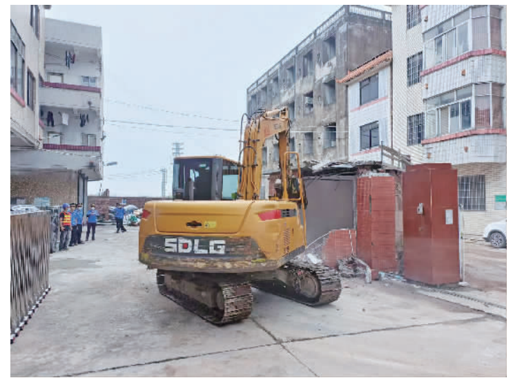
■大型钩机对违建物进行拆除。
