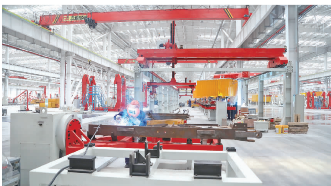
徐工项目一期一号厂房已竣工,设备基本安装完毕。
