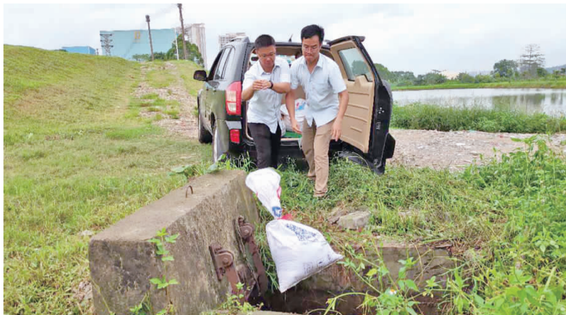
各村居负责人对片区内高程较低的窠闸进行现场检查,做好关闸和塞窠处理。 通讯员供图
