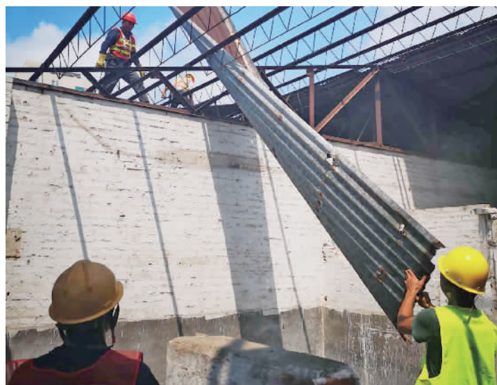
施工人员正在拆除违建。
