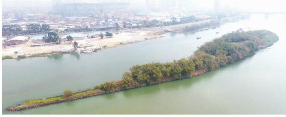
修复后的海心沙实现100%绿化覆盖率。
