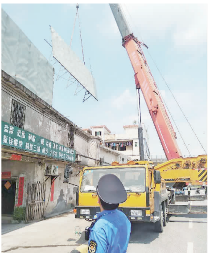
执法人员指挥清拆钩机拆除违规广告牌。(通讯员供图)
