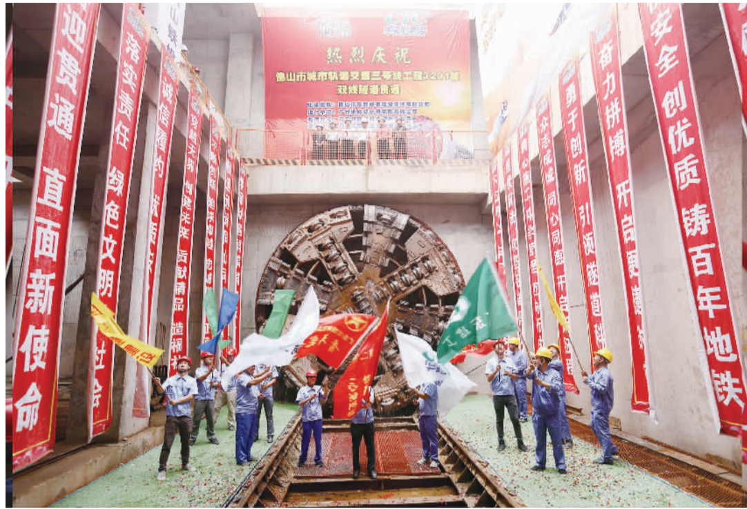
5月15日,地铁3号线工程先行段实现双线隧道贯通。
