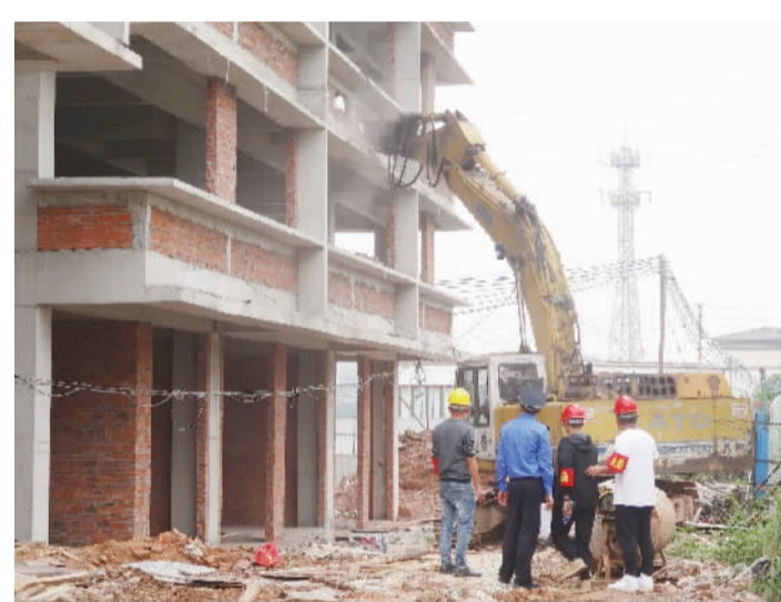
综合执法组对广云路穆院路段的两栋违法建筑物进行第一阶段拆除。
