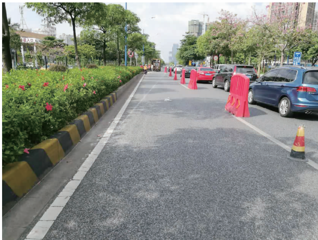
交警部门将掉头缺口设置在距离海五路路口南往北方向、佛平路口北往南方向的红绿灯停止线约180米处,附近车道已围蔽。(通讯员供图)
